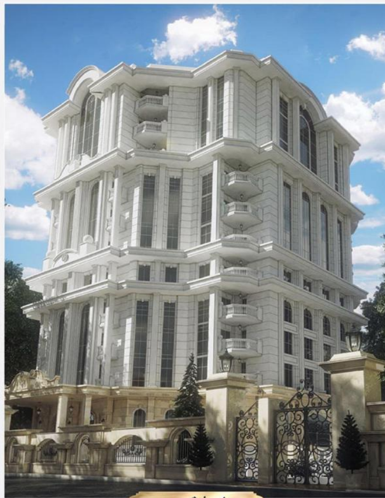
پروژه برج نیلوفرگاردن البیس
